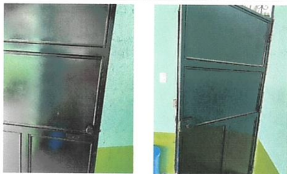
foto 3 cambio de chapas
