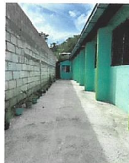
foto 2 reconstruccion de torta de concreto
