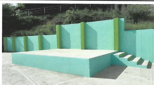
foto 4 pintura en muros
