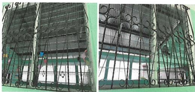
foto 5 cambio de ventanas
