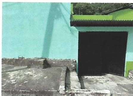
foto 1 torta de concreto
